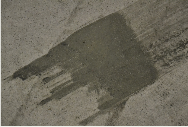
Bild 2. Akryl Silikal Dekor efter 3 år på parkeringsdäck Åkeshov. Slitage ner till betongen efter burnouts.
