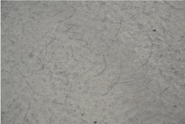
Bild 3. Polyurea Micorea HS efter knappt 2 år på parkeringsdäck Baggen.
