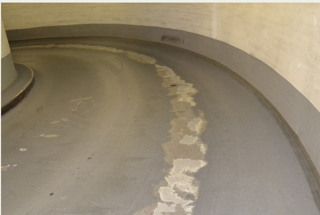
Bild 4. Typisk slitageskada på hårdplastbeläggning i ramp.
